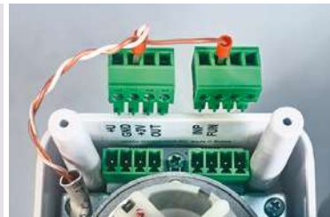
Фото 23. Подключение проводного выключателя
