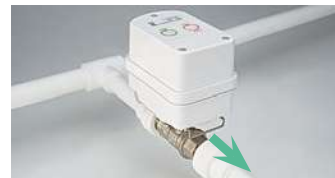
Фото 9. Удаление металлического фиксатора
